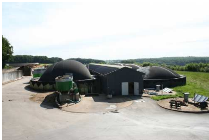
Usine de méthanisation
